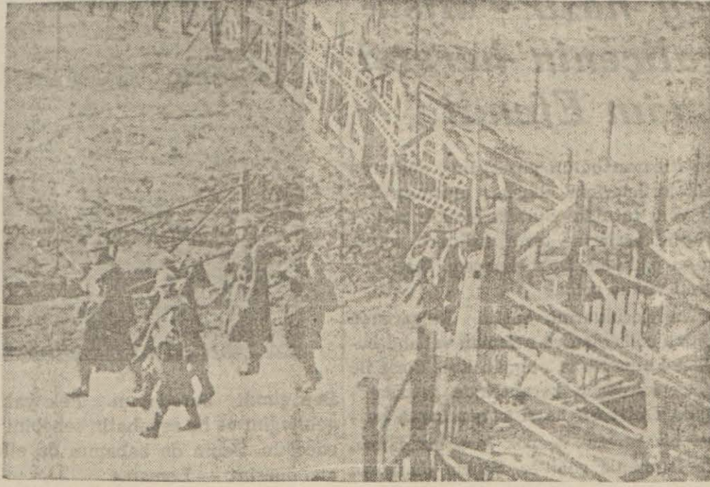
Belçikanın Almanya hududunda bir kısım arazide vücude getirdiği çukuk duvar
